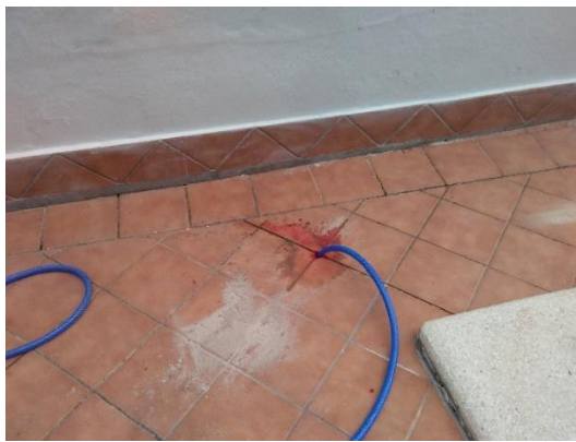
Inyección de agua en el terreno
