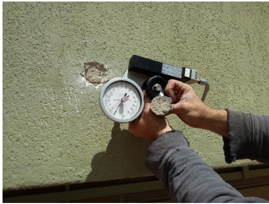
Ensayo de adherencia
