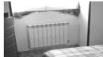
CONDENSACIONES POR FALTA DE AISLAMIENTO EN ZONA RADIADOR (RADIADOR ENCENDIDO).
