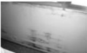
CONDENSACIONES POR FALTA DE AISLAMIENTO EN ZONA RADIADOR (RADIADOR APAGADO).
